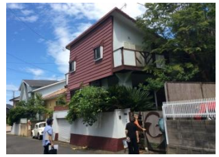
＜空き家の保存状態など確認＞
